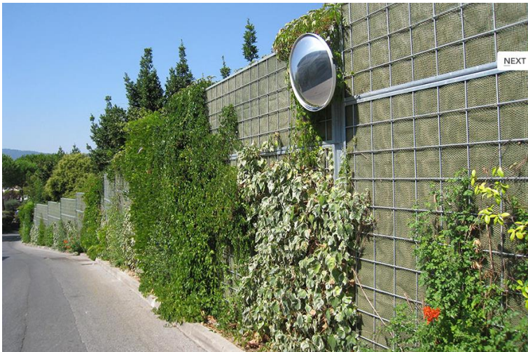
Figuur 8 Geluidsscherm op basis van rotswol met aanplanting – begroeiing mogelijk
