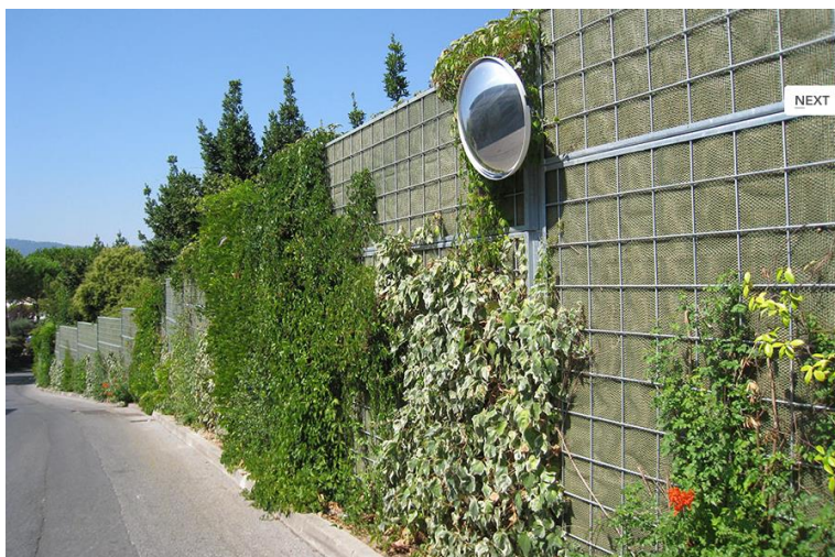
Figuur 20 Geluidsscherm op basis van rotswol met aanplanting – begroeiing mogelijk
