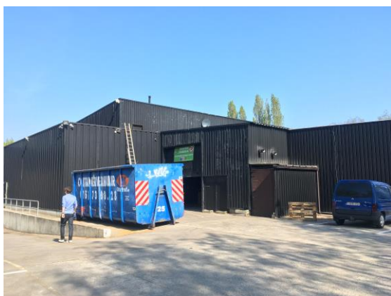
Figuur 7 bestaande toestand, buitengevel ter hoogte van de inkomzone
