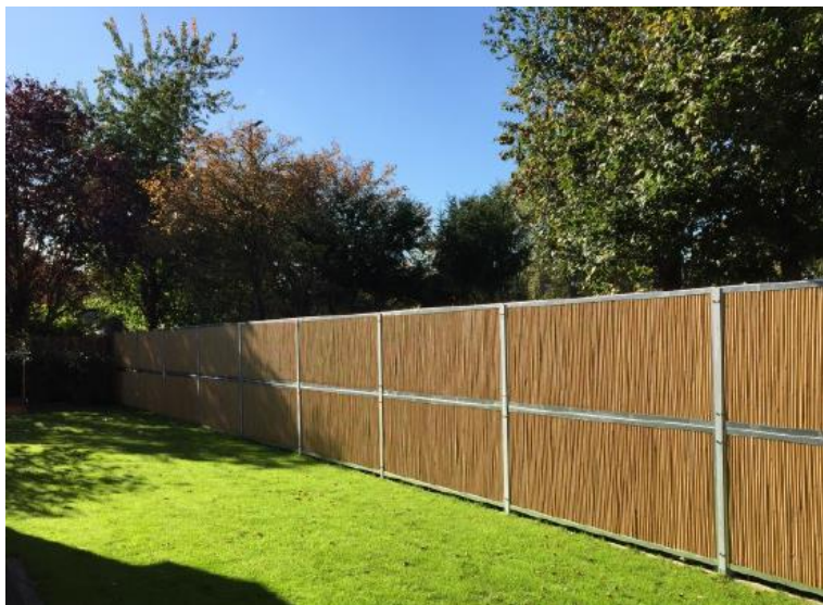
Figuur 21 Geluidsscherm op basis van bamboe – geen begroeiing mogelijk
